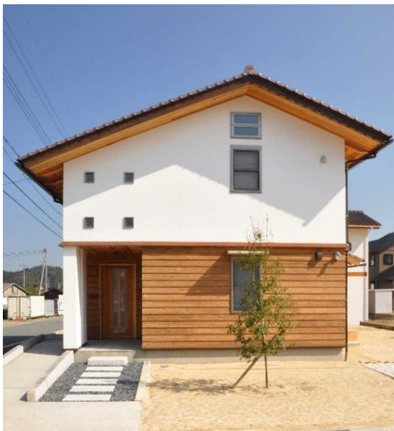
外観〔平成 2 2 年 2 月撮影〕
